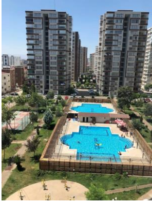
Şekil 33. Çeysa Altınşehir Konutları'nda havuz örneği
