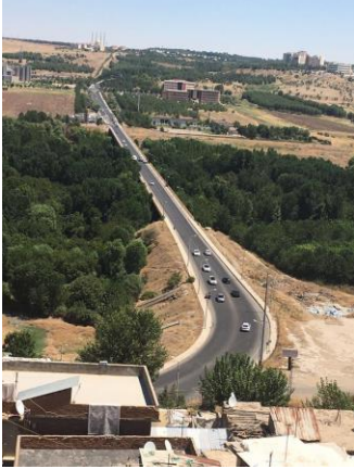
Şekil 25. Dicle Üniversitesi Köprüsü (Fiskaya)
